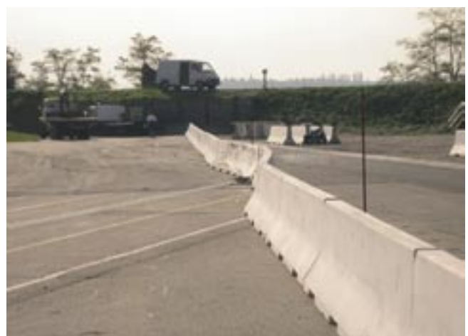
Bild 1: Typische „Bauchbildung“ von Betonschutzwänden bei Einhaltung der Mindestaufstelllänge
