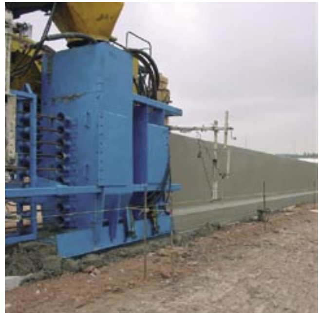
Bild 1: Errichtung einer Betonschutzwand mit Gleitschalungsfertiger (Step-Profil)
