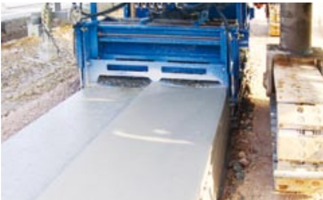
Bild 3: Fundament mit angearbeiteter Entwässergrinne in Gleitschalungsbauweise
