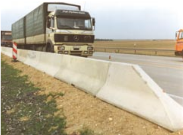
Bild 5: Betonschutzwand auf Tragschicht ohne Bindemittel
