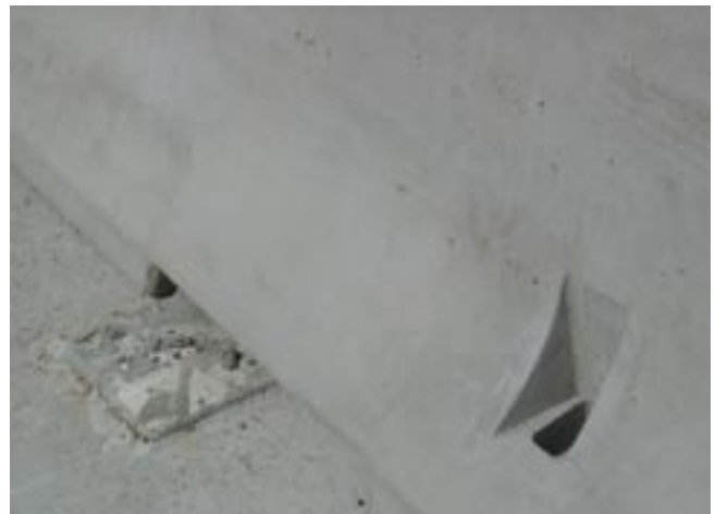
Bild 6: Vorbereitung des Fundaments und der Betonschutzwand für eine Lagesicherung durch einen Erdnagel zur Verminderung des Wirkungsbereichs (Betonschutzwand ist noch nicht in die endgültige Lage versetzt)
