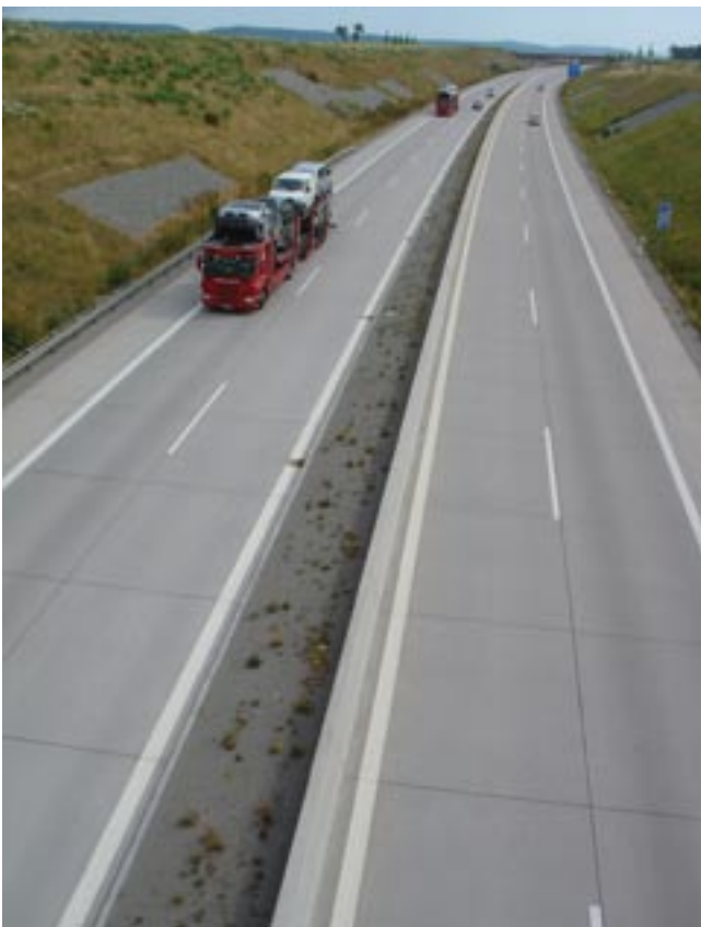
Bild 1: Betonschutzwand auf Betondecke
