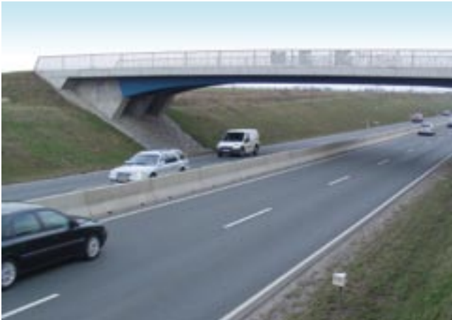
Bild 2: Betonschutzwand auf Asphaltdecke
