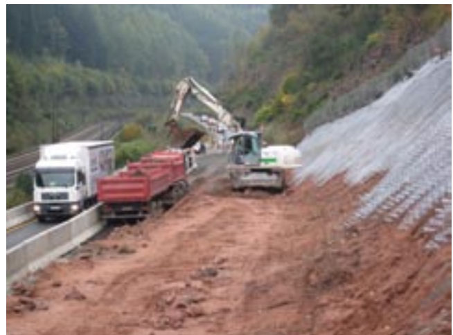
Bild 3: Baustellenabsicherung auf engstem Raum
