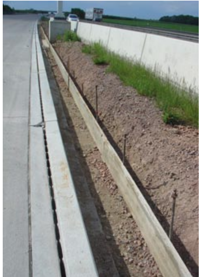
Bild 4: Standschalung für Streifenfundament; bereits verlegte Schlitzwand-Fertigteile
