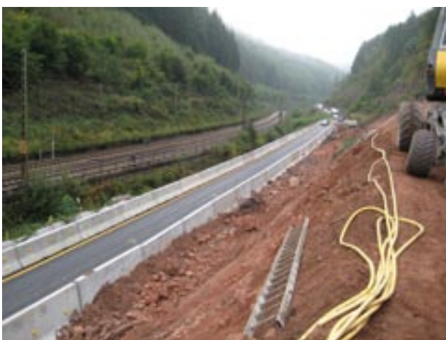
Bild 1: Verkehrsführung im Baustellenbereich zwischen talseitiger und angeschnittener bergseitiger Böschung
